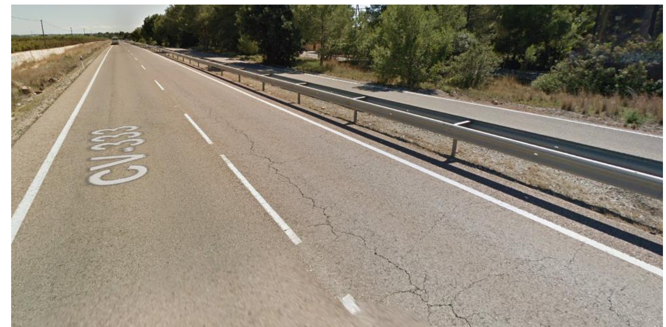
Ilustración 22 – Tramo CV-333 – Separación doble bionda
